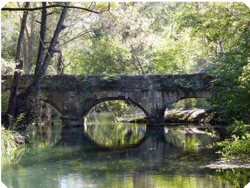
Фото 55. Мост-акведук через реку Чёрную. 2012 г.
