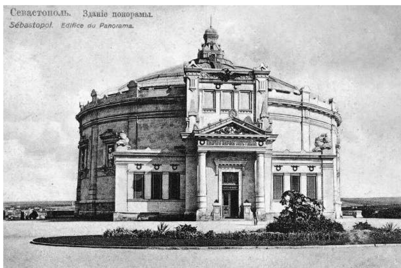
Здание панорамы обороны Севастополя
